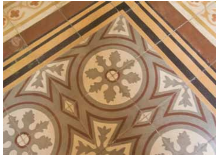
Detail of the original hydraulic tile floors Detall dels paviments de rajola hidràulica conservats
