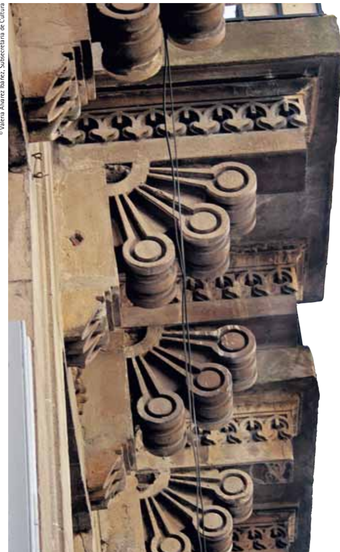
Console brackets supporting the balconies Mènules dels balcons
