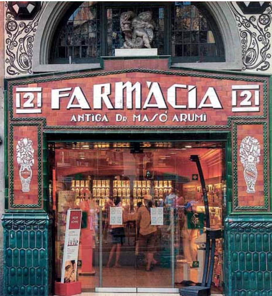
The façade of the Dr Masó pharmacy was designed by Smith in 1917 La façana de la farmàcia Dr. Masó va ser dissenyada per Smith el 1917
