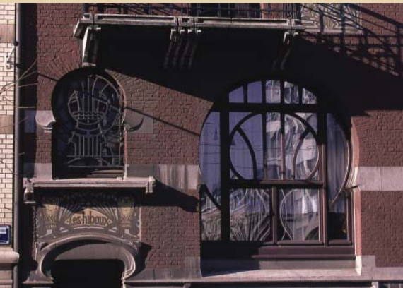
Edouard Pelseeneer, 1899. Les Hiboux apartment building, at 55, Avenue Brugmann, in Brussels Edouard Pelseeneer, 1899. Edifici d'habitages Les Hiboux, a l'avenue Brugmann 55, Brussel·les
